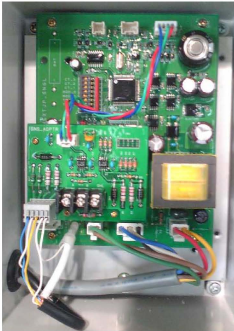
BeLinkモニター内部 結線状況
